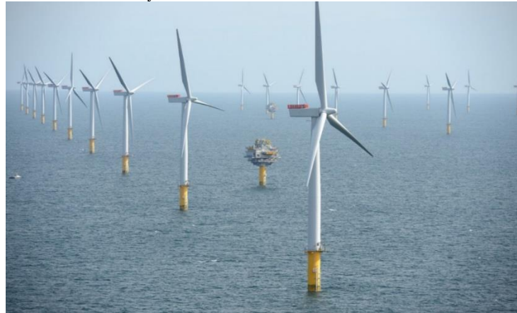
Рис. 1. Шельфовая электростанция Sheringham Shoal, Великобритания
