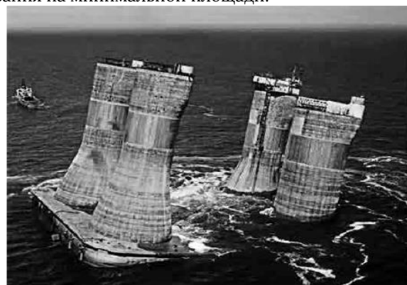
Рис. 2 Затопление железобетонного основания платформы «Лун-А» на северо-восточном шельфе Сахалина на глубине 50 м (www.sakhalin1.ru)
